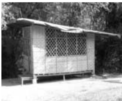
Kindergarten im Bergdorf Compostella.
