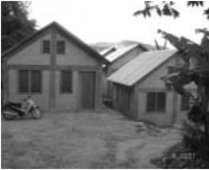
Hausbauprojekt in Talisay - jedes Haus besteht aus einem großen Raum mit separatem WC.
