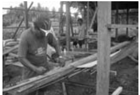
Das Gebäude für die Korn- und Reismühle im Rohbau.
